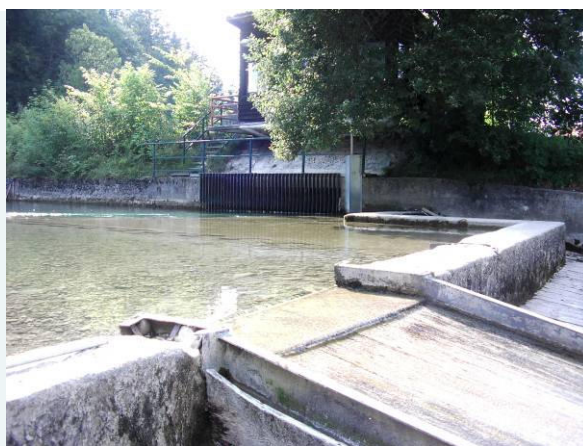
Ausleitungsbauwerk für das Kraftwerk Amtermühle. Ab hier führt die Ammer nur eine geringe Restwassermenge.
