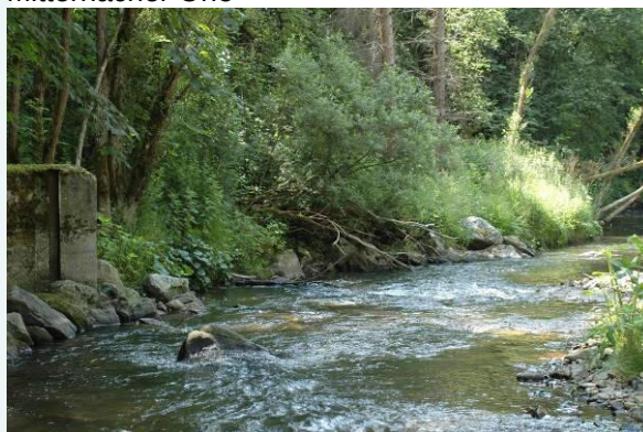
Mitternacher Ohe nach Schleifung des Wasserkraftwerks
