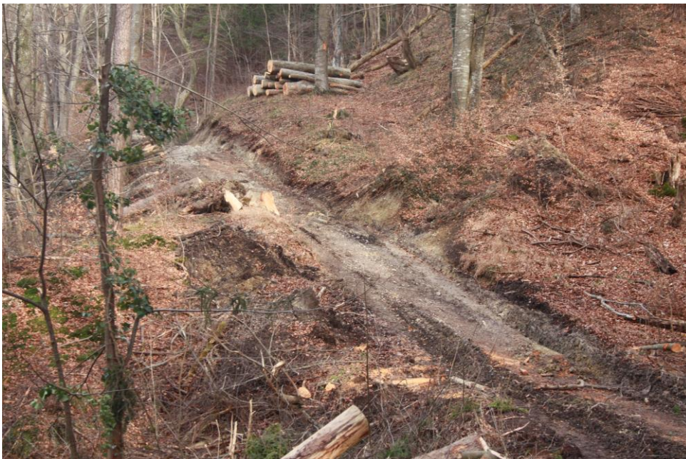
Abb. 8: Ca. 50 Meter langer und bis zu 3,5 Meter hoher Hanganschnitt entlang dieser Weganlage in der Südseite der Schlucht. Foto 08. 02. 2012.
