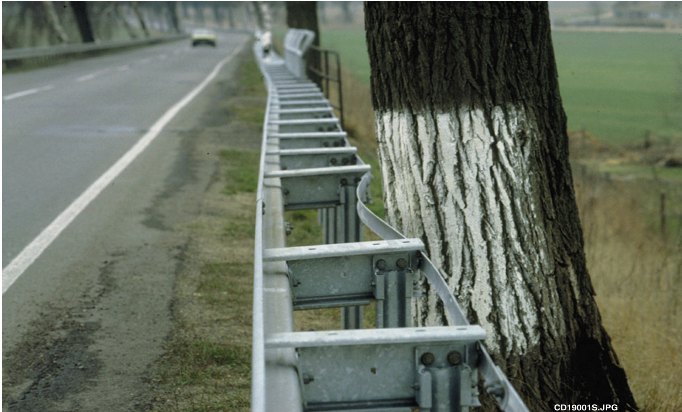
Beispiel für Schutzplanken bei Bäumen mit geringem Abstand zum Fahrbahnrand
